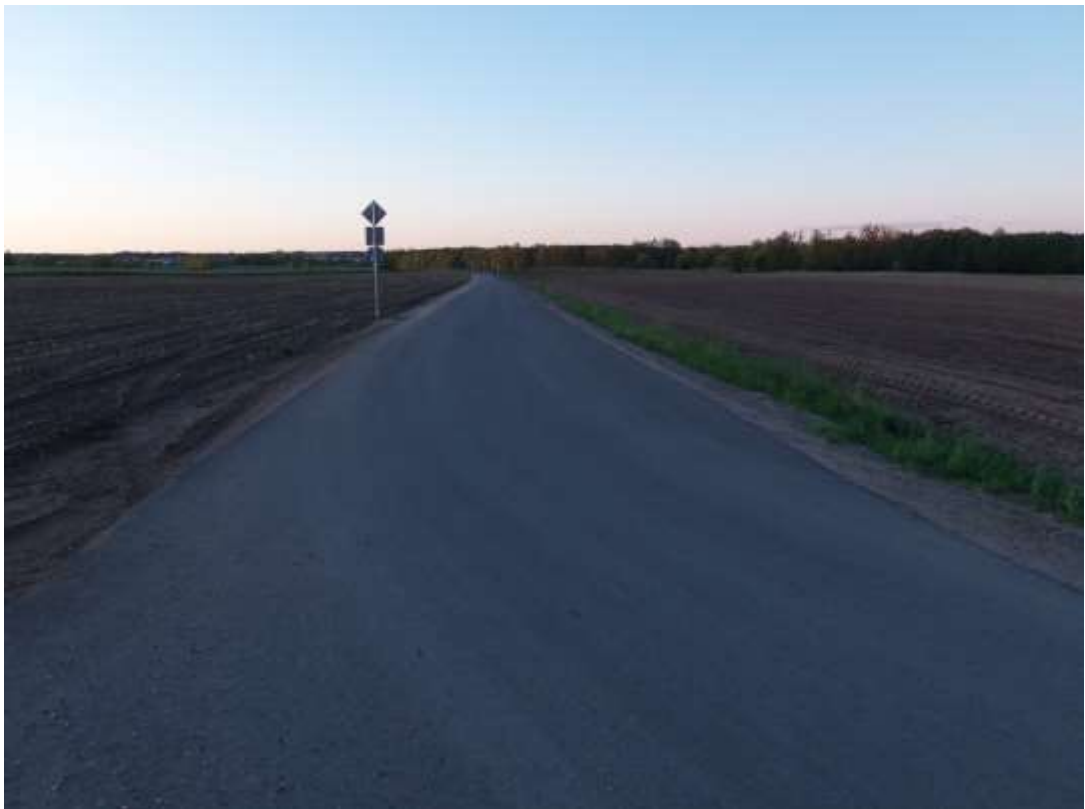
fot. 6 - Droga gminna Zalesie – Sulewo-Kownaty po przebudowie
