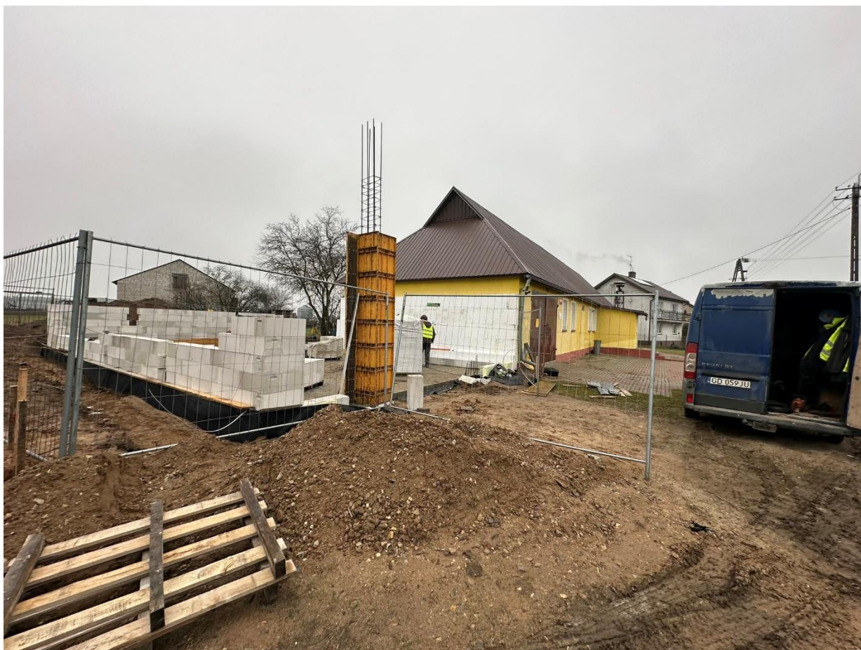
fol. Przebudowa garażu jednostki OSP Kędziorowo
