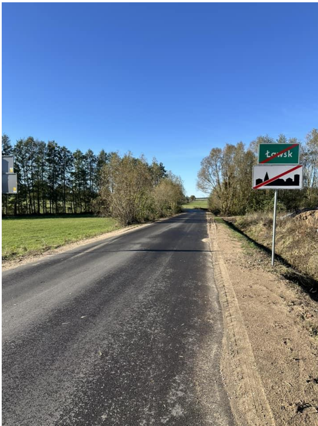
fot. Przebudowa drogi Ławsk - Ciemianka
