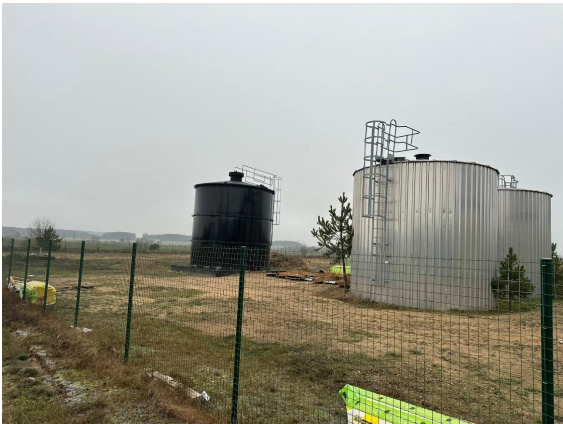
foto. Nowo wybudowana studnia na Stacji Uzdatniania Wody w Wąsoszu
